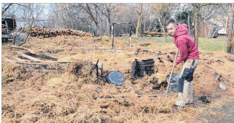
Mario Hinze, technischer Mitarbeiter des Bauspielplatzes, kann an der Brandstelle nur noch das angekohlte Stroh beiseite schieben. Das Strohballenhaus ist zusammengelassen. Es sollte der neue Ziegenstall werden. Foto: Rainer Schweigel
